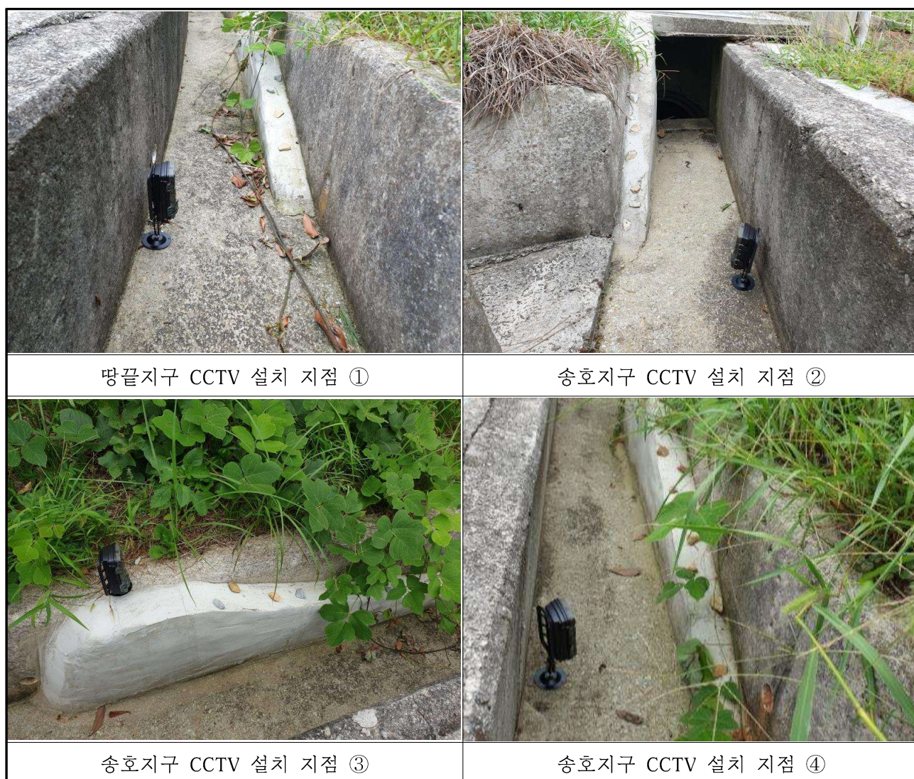
〈사진 3.2.2-5〉 생태측구 모니터링장비(CCTV) 설치 현황
